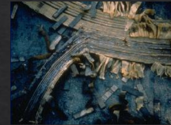
Un transformateur détruit
